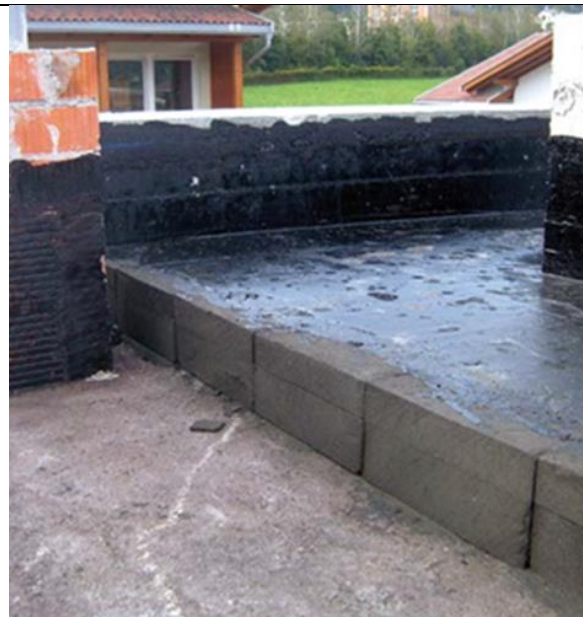
Stogo hidroizoliacija ir apšiltinimas koriniu stiklu
