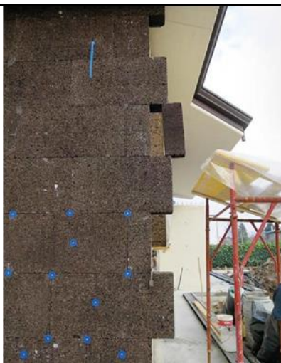
Išorinė izoliacija kamštinėmis plokštėmis
