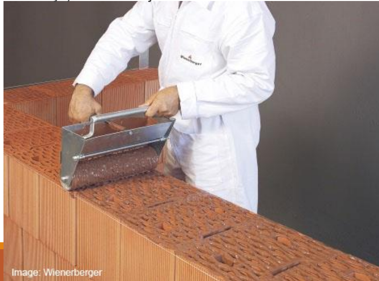
Autoklavinės akytojo betono arba plytų sienos su perforuotomis labai porėtomis plytomis (užpildytomis izoliacija) išklotos klijais
