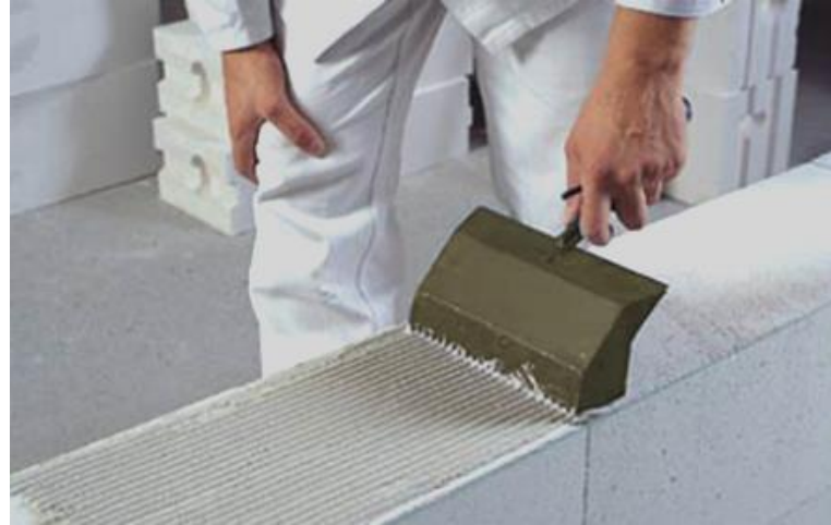
Autoklavinės akytojo betono arba plytų sienos su perforuotomis labai porėtomis plytomis (užpildytomis izoliacija) išklotos klijais
