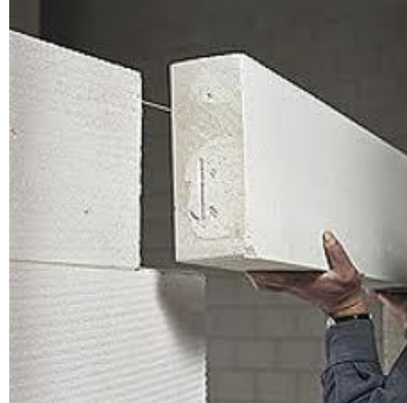
Autoklavinės akytojo betono arba plytų sienos su perforuotomis labai porėtomis plytomis (užpildytomis izoliacija) išklotos klijais
