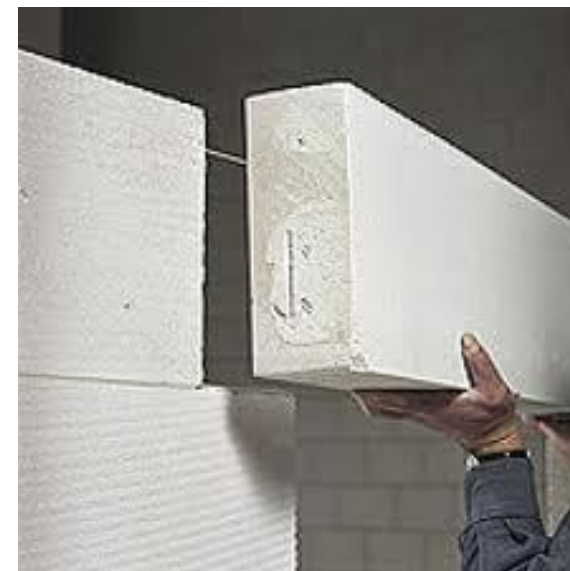
Pareti in calcestruzzo aerato autoclavato o in mattoni con mattoni forati ad alta porosità (ev. riempito con isolante) posato con colla
