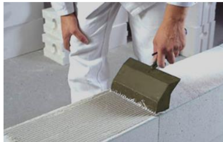
Pareti in calcestruzzo aerato autoclavato o in mattoni con mattoni forati ad alta porosità (ev. riempito con isolante) posato con colla
