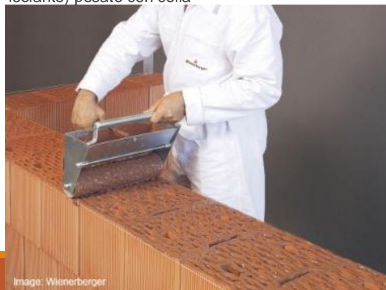
Pareti in calcestruzzo aerato autoclavato o in mattoni con mattoni forati ad alta porosità (ev. riempito con isolante) posato con colla
