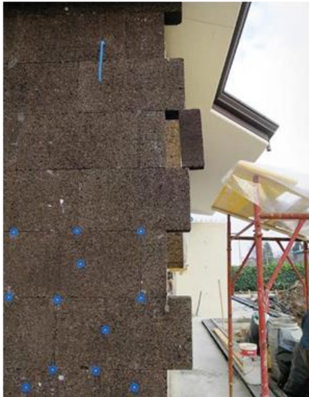
Isolamento esterno con pannelli di sughero
