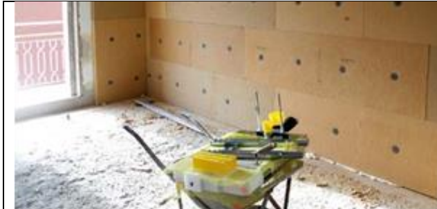
Sopra: Isolamento interno con Fibra di legno Fonte: Agenzia CasaClima
