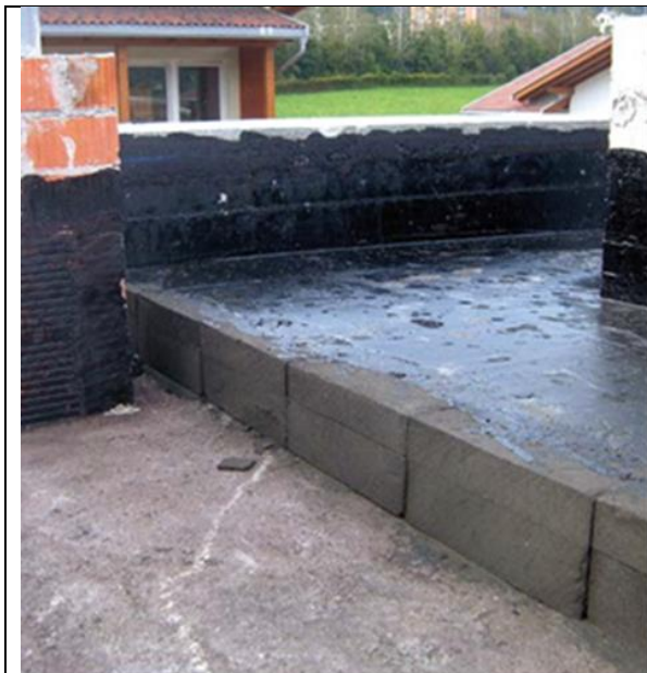
Impermeabilizzazione e coibentazione del tetto con vetro cellulare
